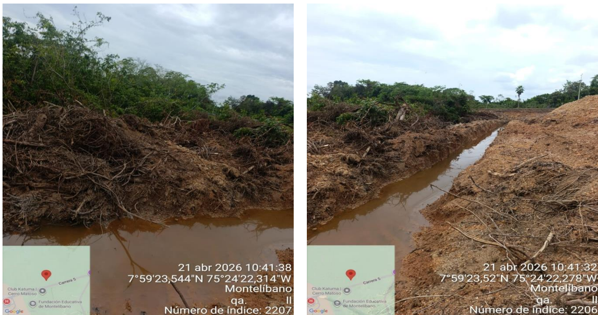
Figura 6. Zona de canal antrópico para desviación del humedal.
